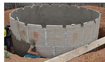
Construção de cisternas
